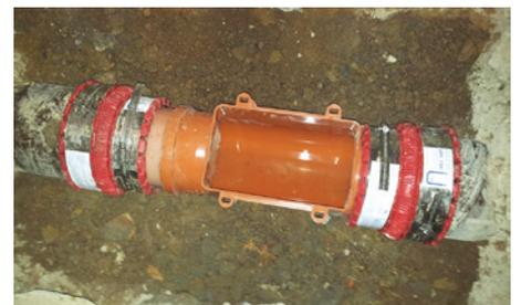
In mehreren Häusern wurden abschließbare Kontrollöffnungen (sog. Revisionsöffnungen) an den Grundleitungen erneuert. Im Falle eines Starkregens verhindern sie den Rückstau des Wassers bis in die Keller.
