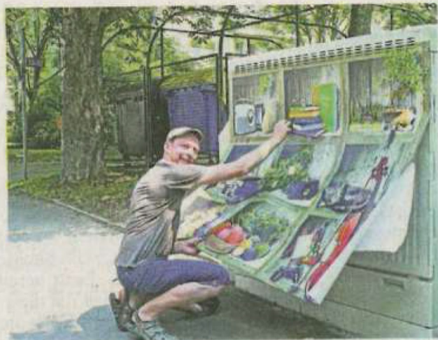
Künstler Axel Ratzer beklebt einen der Schaltschränke. Foto: Dieter Schmidt
