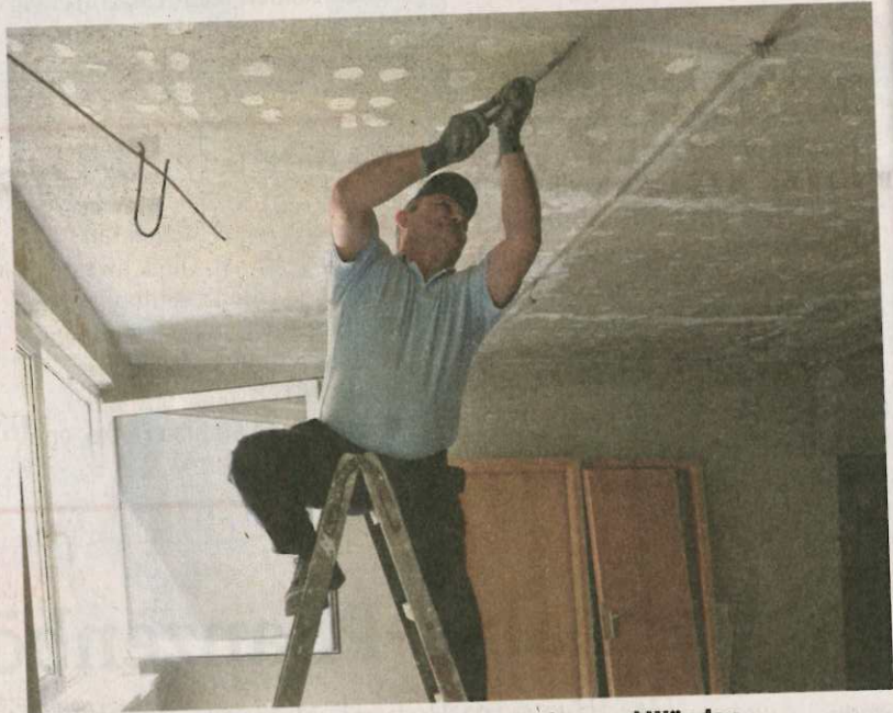
Bülent Fetta entfernt die alte Tapete von Decken und Wänden.
