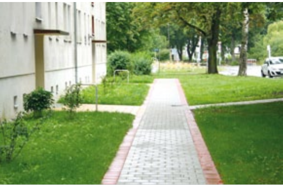
Sanierung Eingangsbereiche Steinbeckstraße 59-63
