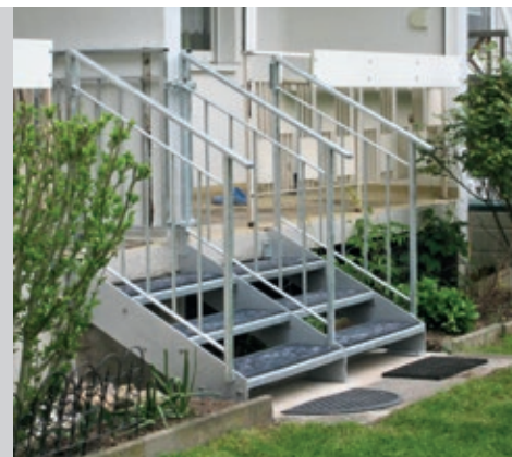
Neue Balkongeländer und Treppen zu den Gärten zieren nun die Zeulenrodaer Straße
