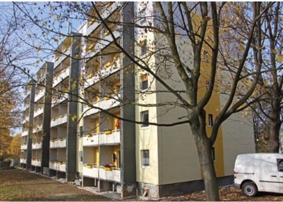
Rückansicht der Steinbeckstraße 31 a-d mit schlichten, neuen Balkonverkleidungen
