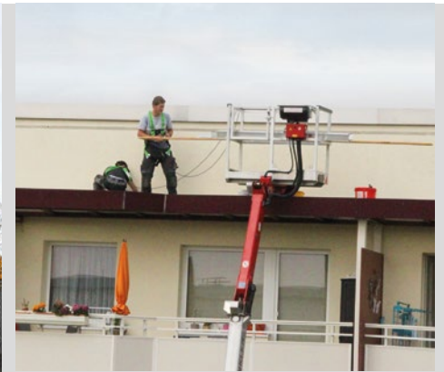
Die Wartung der Dächer in der Zeulsdorfer Straße 63-73 in schwindelerregender Höhe
