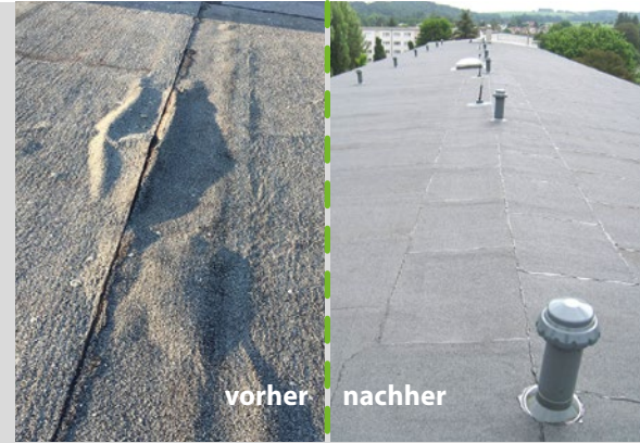
Die Dachhaut der Walter-Gerber-Str. 12–18 ist jetzt jetzt wieder in Topform
