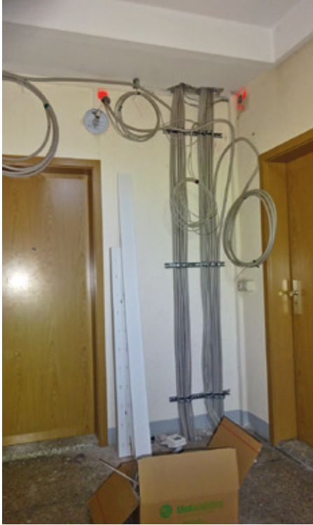
Neuverlegung der Elektroleitungen in den Treppenhäusern
