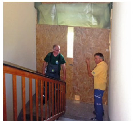
Schutzwand im Treppenhaus zur Vorbereitung des Aufzugsanbaus
