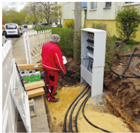
Herstellen neuer Elektrohausanschlüsse
