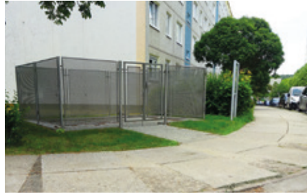
Umverlegung des Containerstellplatzes
