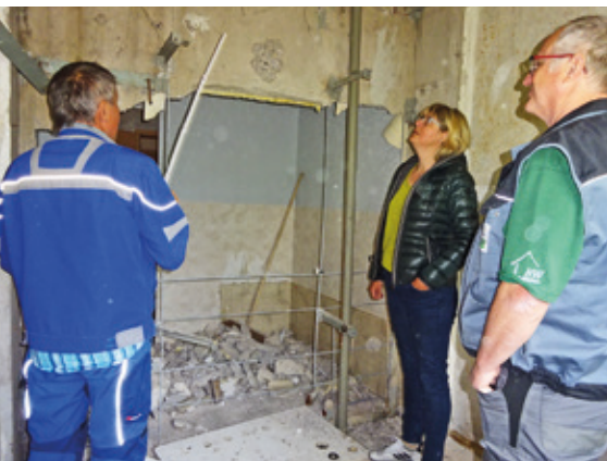
Baubesprechung zur Strangsanierung
