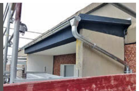
Brüstungserhöhung und neue Balkondacheindeckung für Zu den Wiesen 7–11
