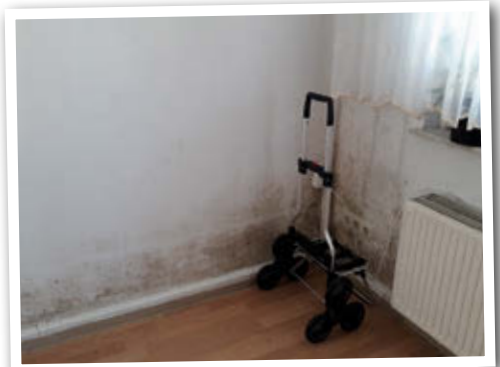
Typische Lüftungs-Schäden: Wird zu wenig geheizt und gelüftet, setzt sich feucht-warme Luft an kalten Wänden und Fenstern ab – ein idealer Nährboden für Schimmelpilze entsteht
