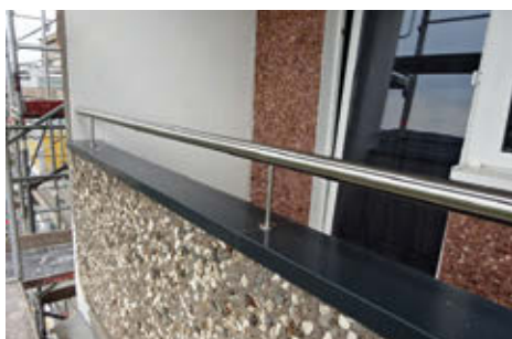
Brüstungserhöhung und neue Balkondacheindeckung für Zu den Wiesen 7–11
