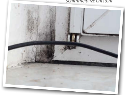
Typische Lüftungs-Schäden: Wird zu wenig geheizt und gelüftet, setzt sich feucht-warme Luft an kalten Wänden und Fenstern ab – ein idealer Nährboden für Schimmelpilze entsteht
