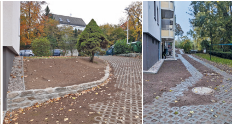
Laasener Straße 62 – 66: Die Außenanlagen wurden fertiggestellt, Zaun und Tor zum Müllplatz und die Kiesstreifen erneuert. Am Giebel des Hauses 66 wurde die Böschung neu eingefasst und balkonseitig Rasengittersteine für die Zufahrt verlegt. Die Wohnhäuser konnten mit den energetischen Maßnahmen von der Energieeffizienzklasse D mit durchschnittlich 125,9 kWh/m 2 a auf die Energieeffizienzklasse B mit durchschnittlich 71,9 kWh/m 2 a verbessert werden. Vor dem Hintergrund steigender Energiepreise bietet diese Entwicklung unseren Mitgliedern zukünftig einen finanziellen Vorteil.
